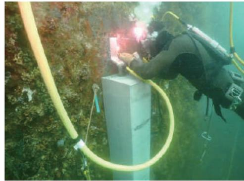
写真4 水中溶接用フロートケーブル作業風景
