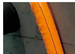
写真5 電線保護シートをマジックテープ留め
