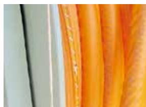
写真4 電線保護シートの両側を糸で縫い付け
