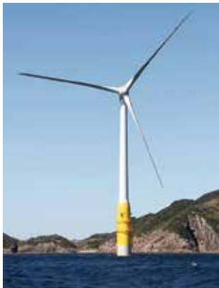
図1 長崎県五島市に設置された浮体式洋上風力発電施設 (出典：五島市HP)
