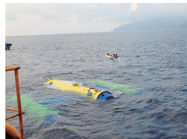
図3 口之島沖に設置中の「かいりゅう」
