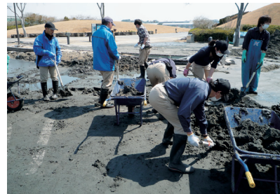
人力による泥の撤去
