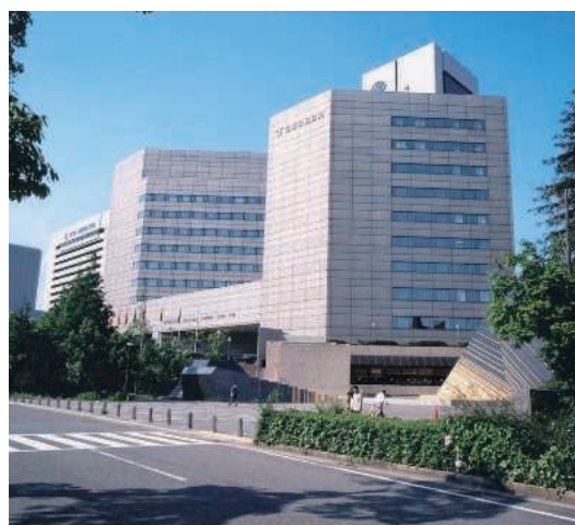
Kobe International Conference Center / 神戸国際会議場
