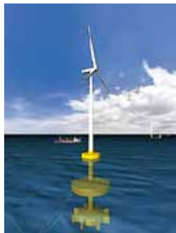
図2：福島沖で実証予定の浮体式洋上風力発電設備 提供：福島洋上風力コンソーシアム
